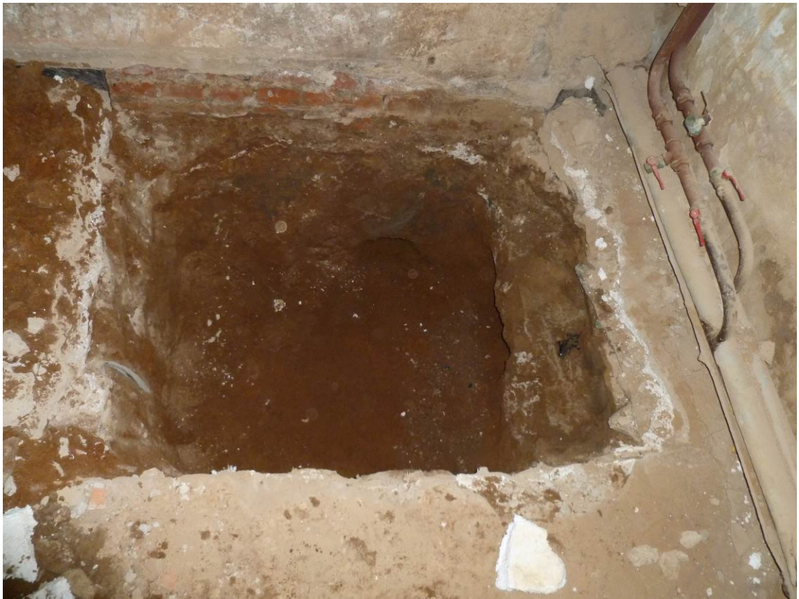
Общий вид шурфа №1
